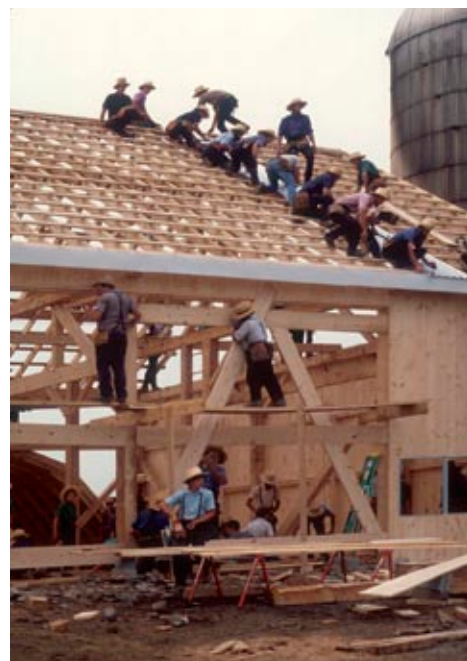
«Barnraising». A ajuda entre os vizinhos de uma comunidade é uma das mais significativas bases civilizatórias dos Amish. O esforço colectivo permite fazer as obras de maior envergadura.
