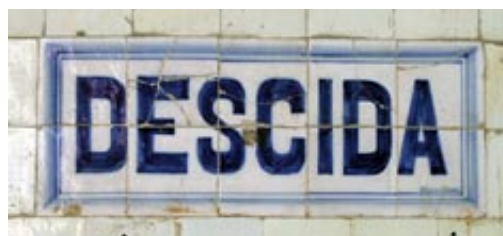
Painéis de letras em azulejo, mas não modulares. Mercado do Bolhão, Porto, Portugal.
